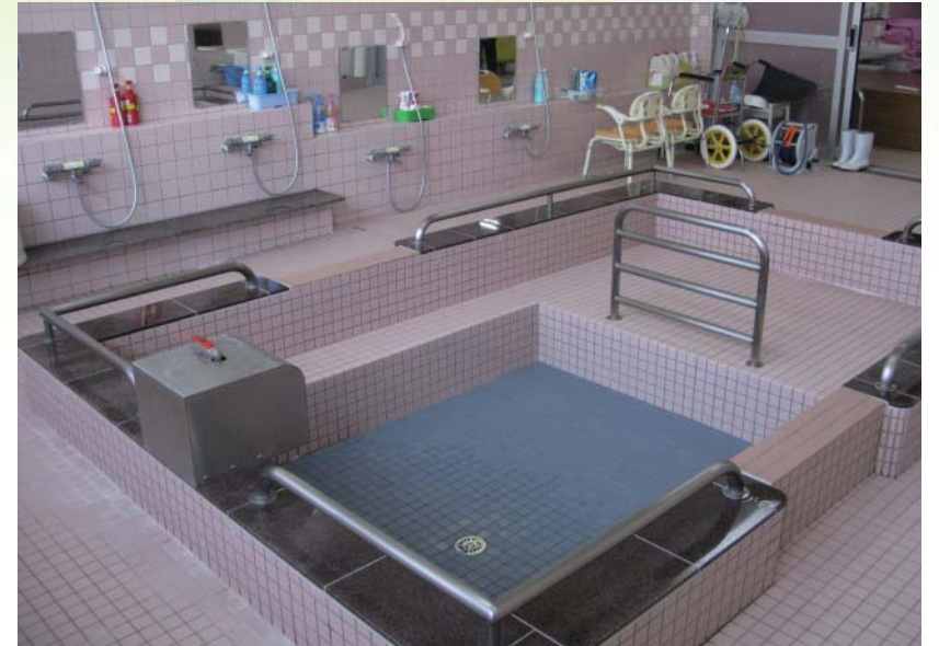
動線を考えて設置された浴室
