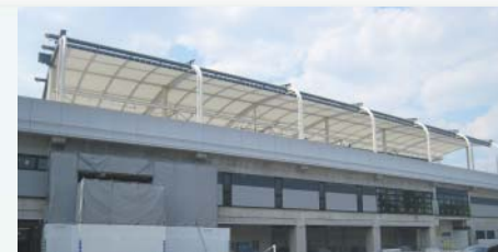
上：着々と工事が進む淀駅
