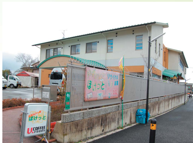
手作りの看板を掲げる作業所の外観
